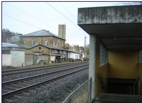
Standort Hp Schonungen an vorhandener Unterführung
