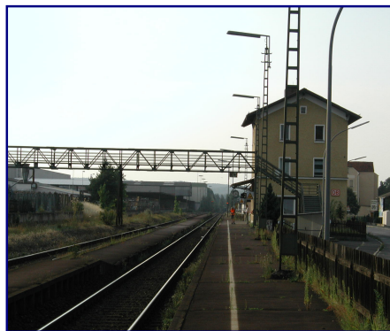
Station Wernberg – Haus- und Mittelbahnsteig
