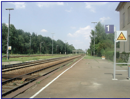
Station Irrenlohe – Höhengleicher Bahnsteigzugang
