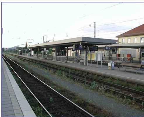
Blick auf den zukünftigen S-Bahnsteig Gl. 2/4
